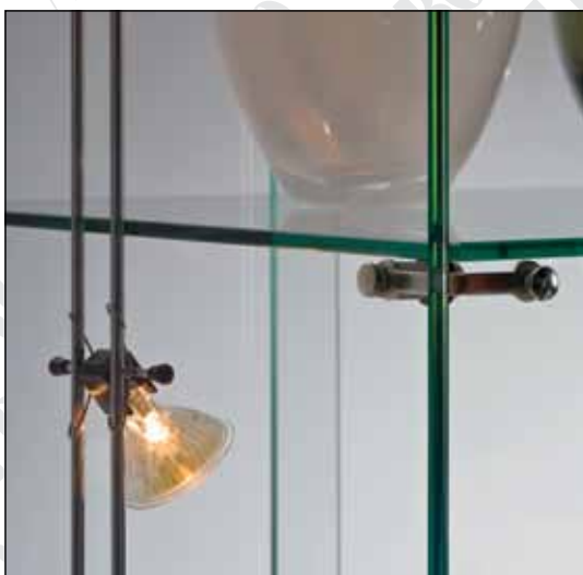
oświetlenie boczne, łączenie szyb
